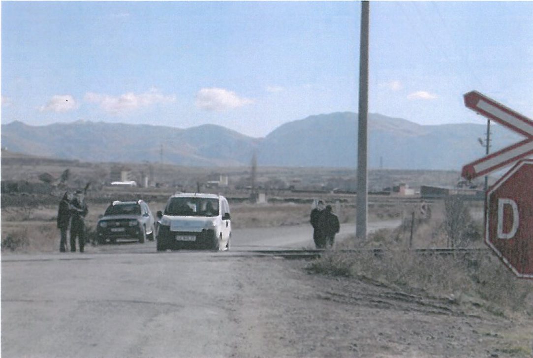
Resim 7 (Hemzemin Geçit Kaplamasının Genel Görünüşü ve Dur Levhası Görüntüsü)
