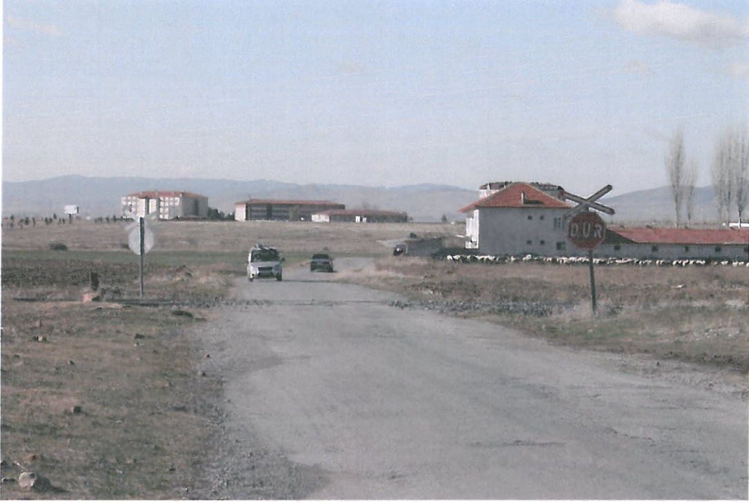
Resim 6 (Hemzemin Geçit Kaplamasının Genel Görünüşü ve Dur Levhası Görüntüsü)
